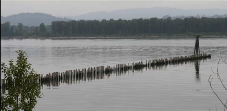
Spur Pile Dike
