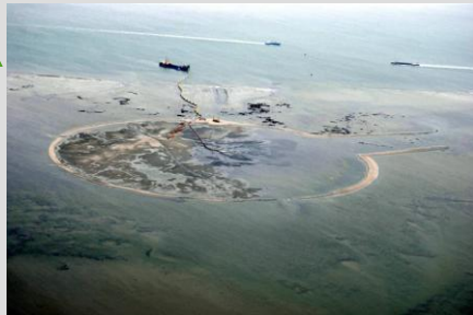
Galgeplaat shoal nourishment
