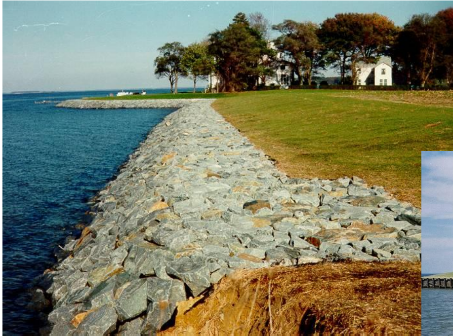
Rip-rap or Revetment
